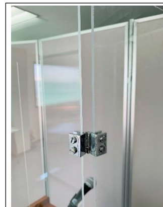
■接合部ズーム 固定金具でしっかり接合
